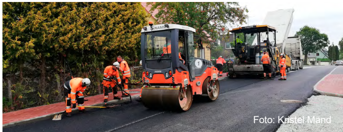
Asfalteerimistööd Koidu tänaval.
